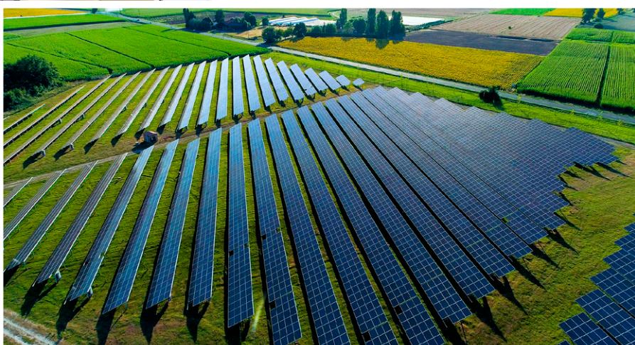
Figura 1 - SFV com painéis no topo das estruturas e usinas no solo.
